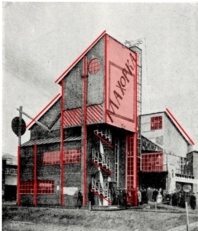
Рис.1. Павильон «Махорка», К.С. Мельников, 1923 г., схема работы структурных элементов
